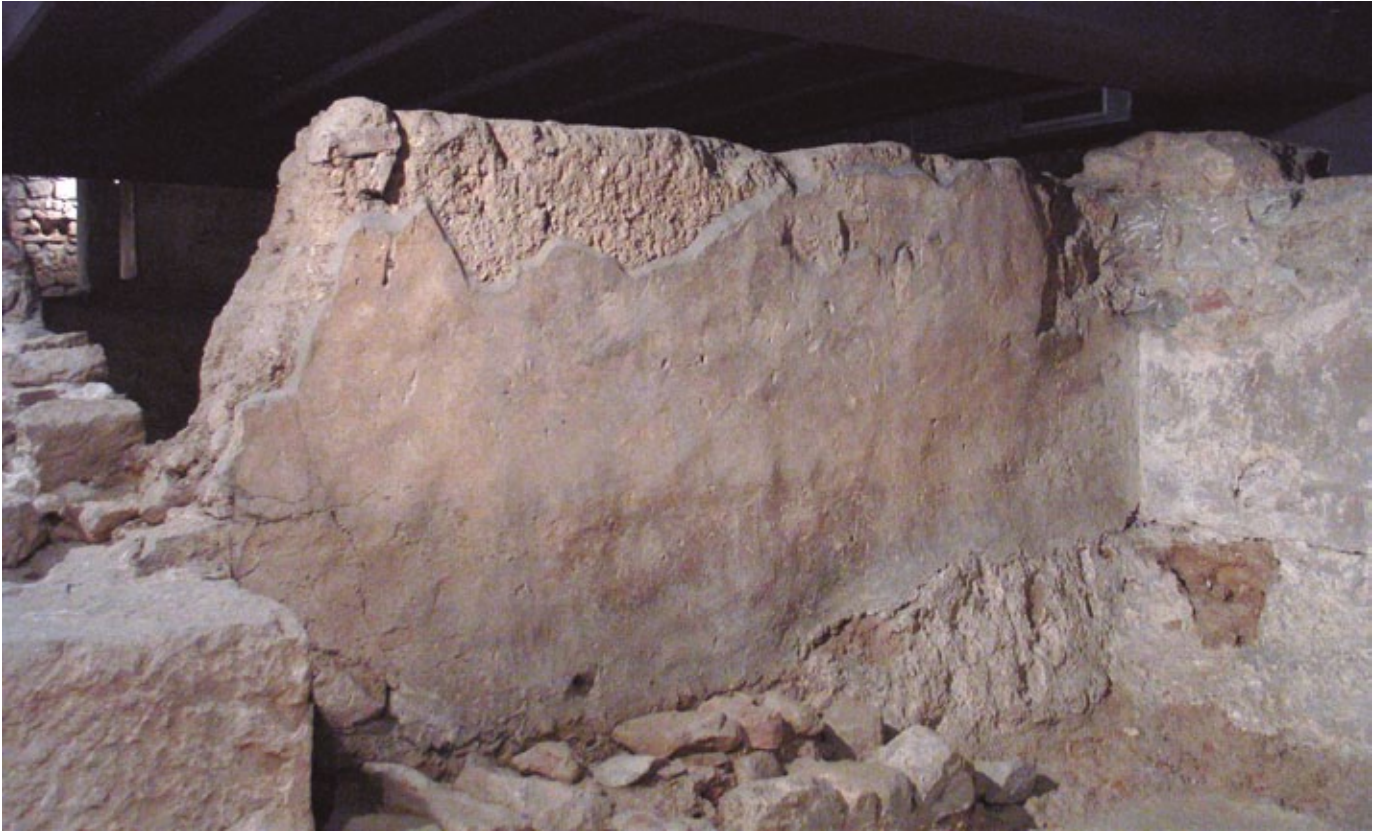
Figura 14 Estructura de tapial. Plaza del Rey. Barcelona. Siglos V-VI. [Fotografía: P. Vivas-MUHBA]
