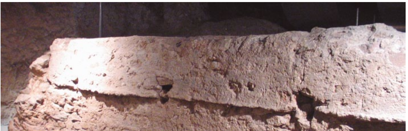
Figura 15 Zócalo de una pared de tapial. Plaza del Rey. Barcelona. Siglo VI. [Fotografía: P.Vivas-MUHBA]
