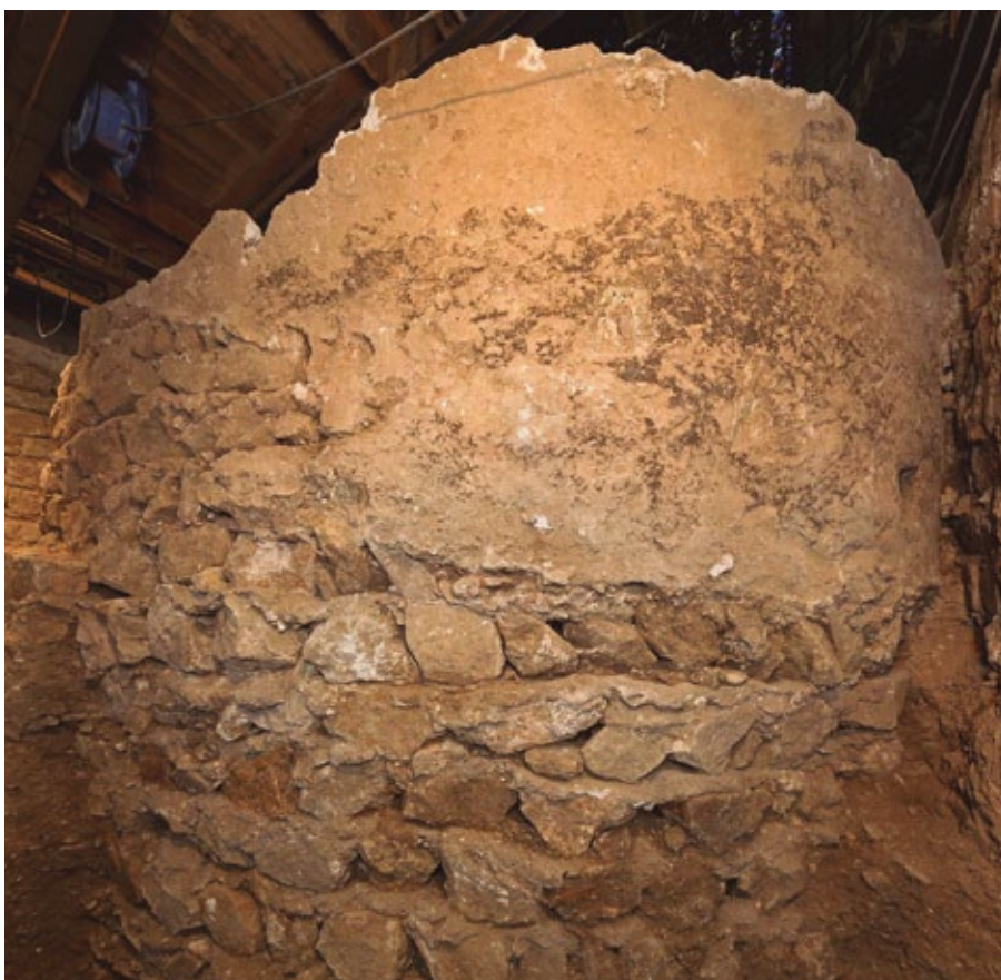
Figura 12 Ábside oriental de la basílica triabsidada. El cimiento presenta la técnica del pseudo spicatum . Siglo VI. (Basílica de los Santos Mártires Just i Pastor). [Fotografía: P. Vivas-Parroquia de Sant Just i Pastor]
